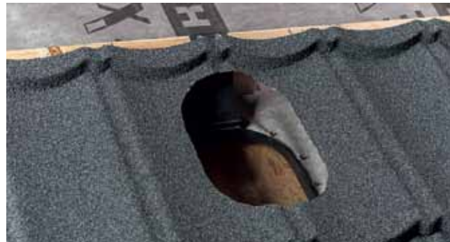
Рис. 38 а. Проходной элемент (DECRA) для панели Classic
